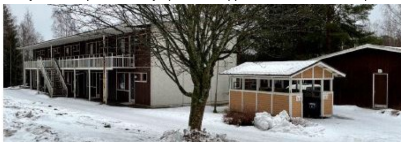
Kuva. Tontin 6319–1 asuintalo, jätekatos ja talousrakennus
